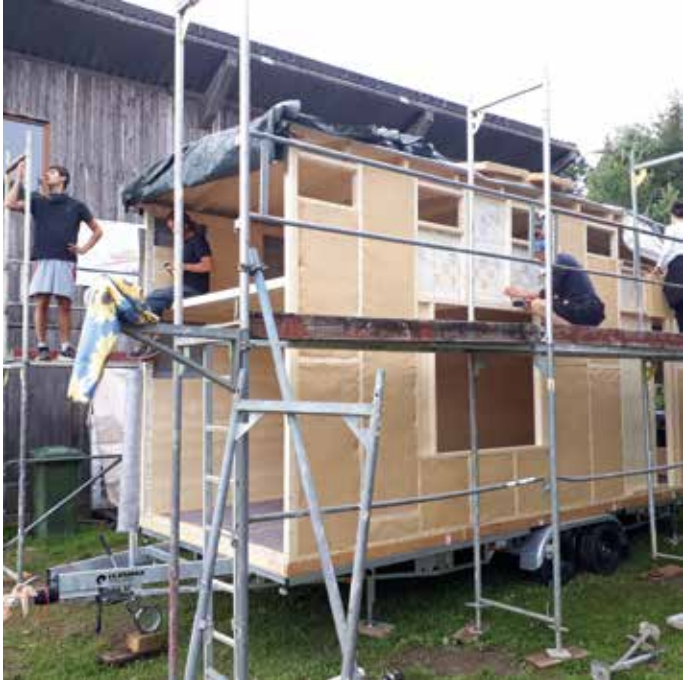
Inzwischen ist der Rohbau fertig: Freiwillige beim Bau des Tiny Houses
